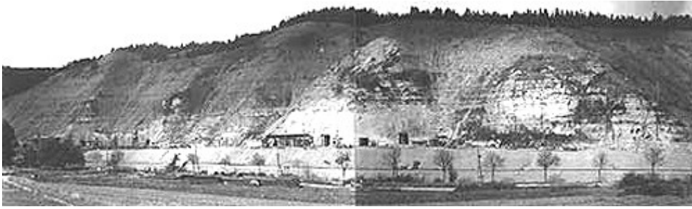
Historische Aufnahme von den Baurbeiten im Jonastal. © Archiv der Gedenkstätte Buchenwald.
