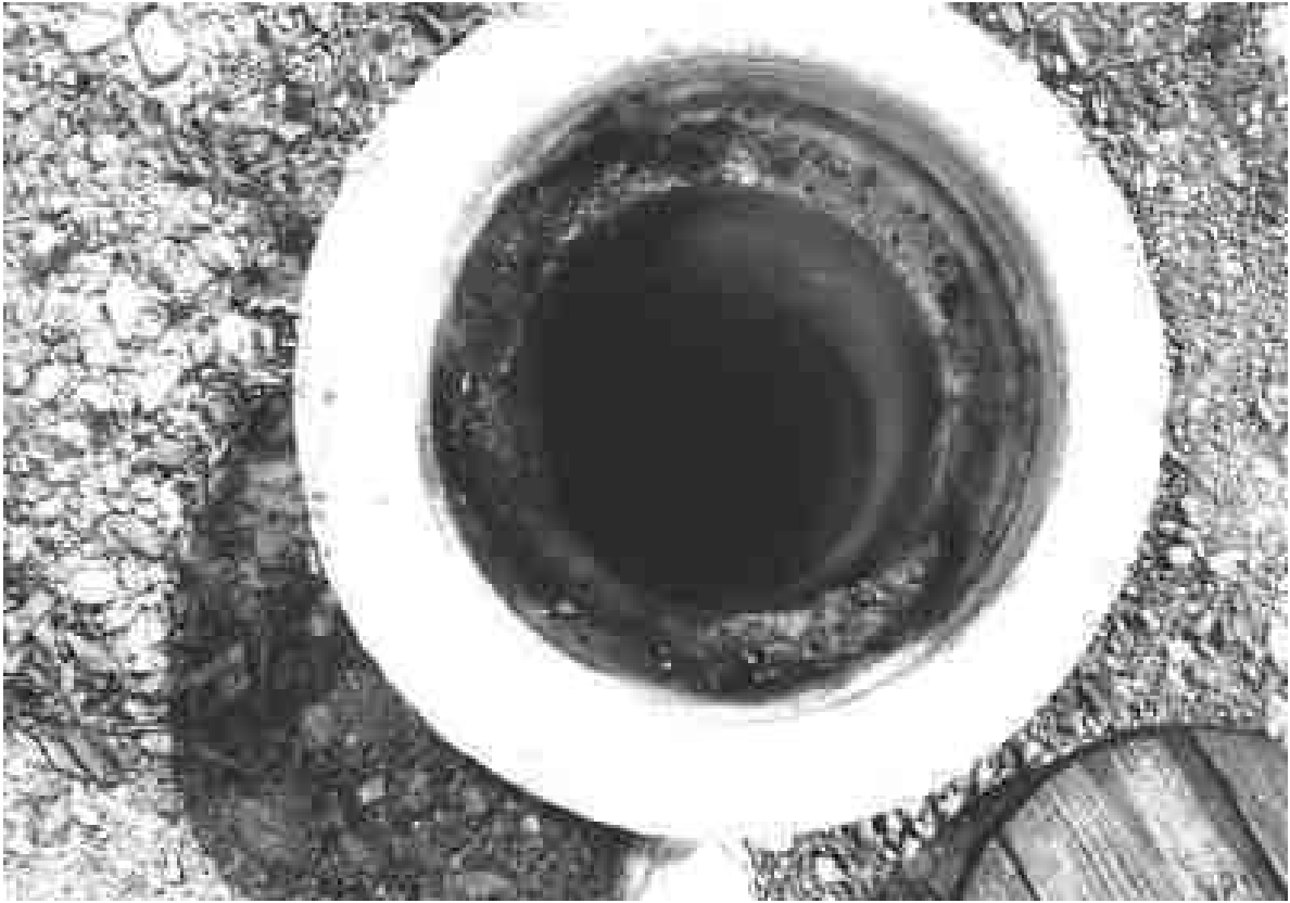
Abb. 7: Blick in das nordöstliche Rohr: es ist trocken, weil die Blind Spring verfehlt wurde.
