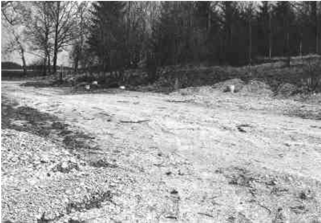
Abb. 6: Im nordöstlichen Bereich hat man versucht, auch die zweite Blind Spring durch ein in die Erde getriebenes Rohr (Pfeil) zu treffen. Wegen der fehlenden Meter-Angeben hat man die BS jedoch verfehlt Mit einem Rutengänger wäre ihnen das nicht passiert...! (Blick in Richtung Nordosten).
