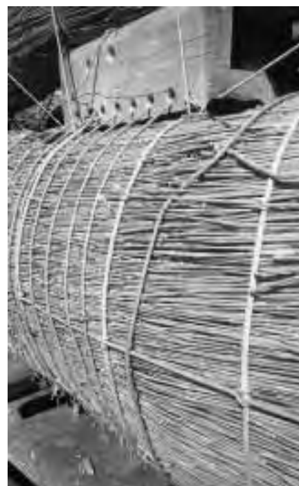
Abb. 10b: Die Mastbefestigung
