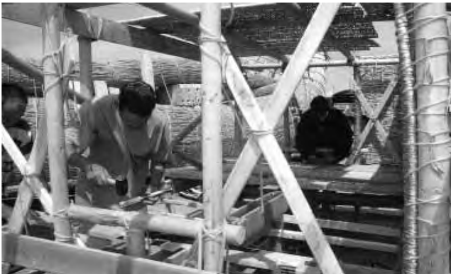
Abb. 13a: Der Hüttenbau
