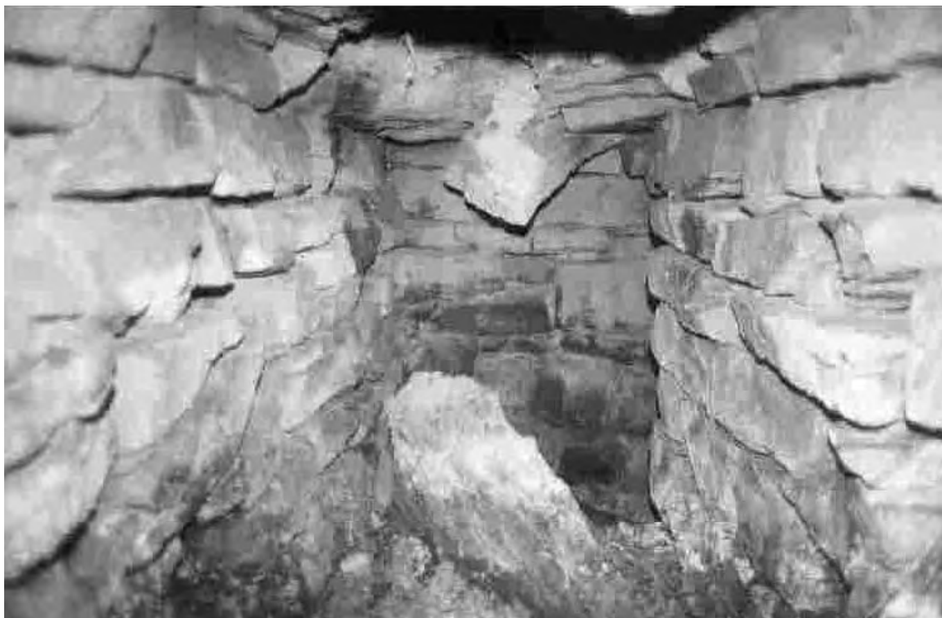
Abb. 6: Blick in die Grabkammer. Wände aus trocken gemauerten Bruchsteinen, teils mit Meißel gespitzt. Die Decke ist geborsten, das Inventar noch unberührt (Foto: Haug)
