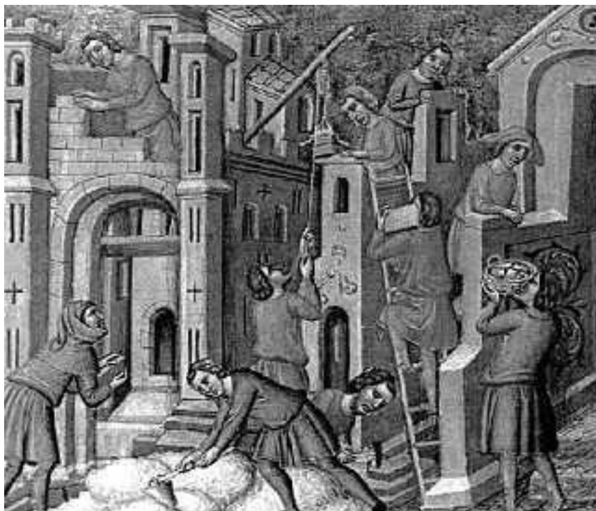
Kathedralenbauer im Mittelalter: Mörtel wird in großen Mengen gemischt und im Eimer nach oben gezogen. Rechts im Korb sieht man geschlagene Steine, möglicherweise die künftige Betonfüllung.
