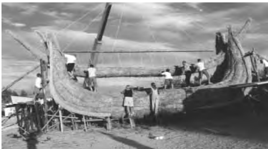
Abb. 10a: Maßarbeit! Die Mittelrolle passte genau zwischen beide Kompaktbündel. Alle anderen Arbeiten am Schilfboot wurden wie zu Zeiten der Pyramidenbauer nur per Hand durchgeführt.
