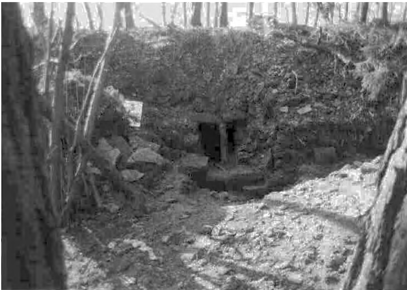
Abb. 3a: Das Portal zur Grabkammer mit Fundament, Schwellenstein, trocken gemauerten Seitenwänden und Dolmendeckplatten (Foto: Haug)
