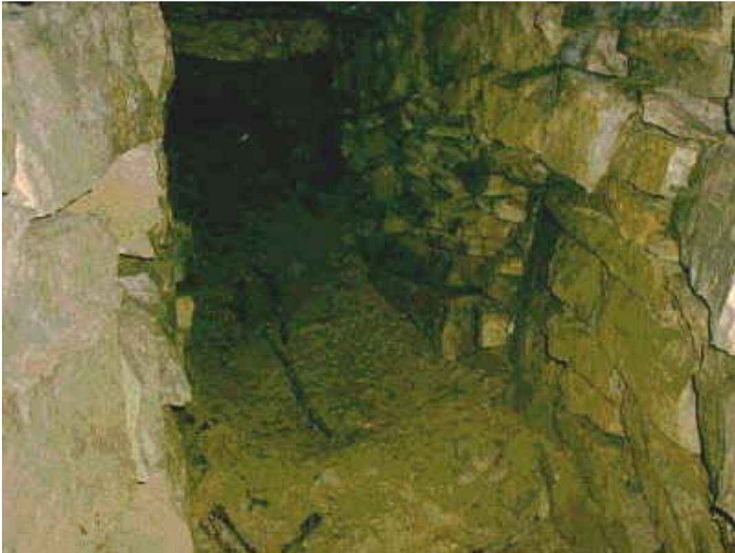
Das Ende des Querganges wird durch einen herabgebrochenen Deckenstein verursacht (Foto: (c) Geise)
