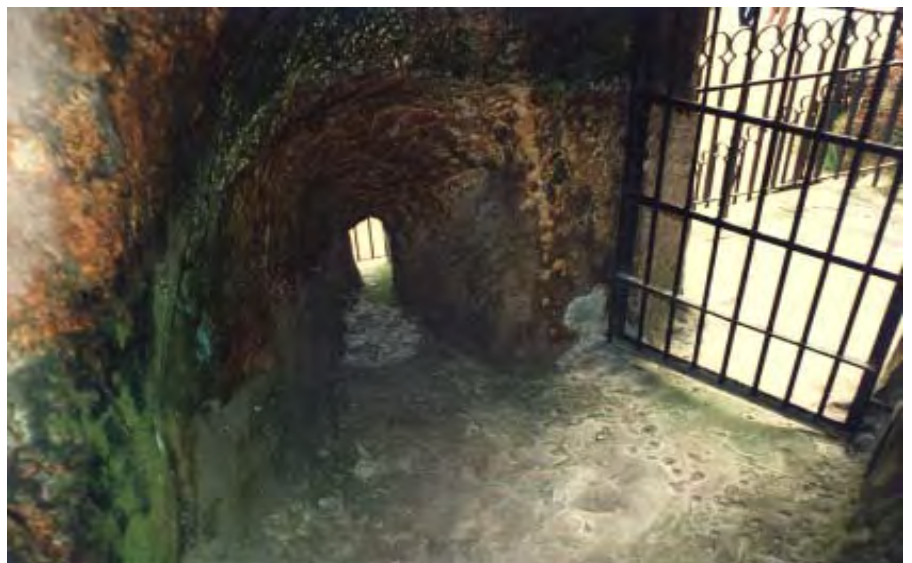
Der „Luftschacht“ gleich rechts neben dem Zugang zur „Petrusgrotte“. Er wurde benötigt, um in diesem Raum über einen längeren Zeitraum ein größeres Feuer unterhalten zu können.
