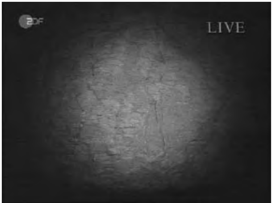
Der Verschlussstein hinter dem Verschlussstein. Er scheint nicht so glatt poliert zu sein wie der durchbohrte. Man erkennt Risse im Material.
