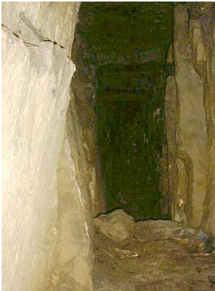
Blick in Richtung des zusammengebrochenen Teiles des Knickganges. In der Bildmitte die Stufe. An der Decke erkennt man die kragende Bauweise der Deckenkonstruktion.
