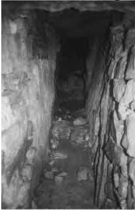
Abb. 17: Stufen einer Steintreppe am Ende des Winkelgangs
