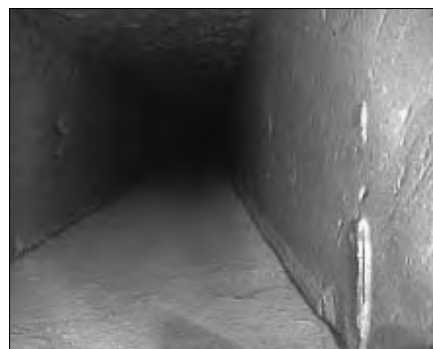
Der „Luftschaft“ in der „Königinkammer“, durch den die Roboter geschickt wurden. Die Vorsprünge (z.B. rechts) wurden bisher noch nicht untersucht.
