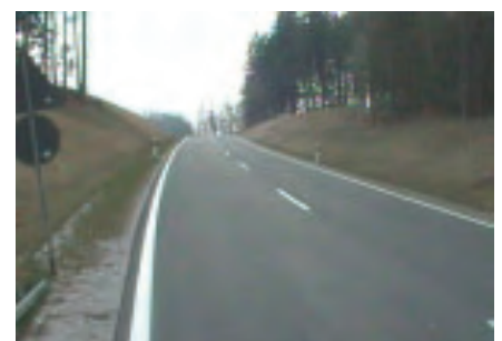
Die begradigte Straße zwischen Wessobrunn und Rott (Blickrichtung Wessobrunn). Die Gefällstrecke wurde ausgeglichen.
