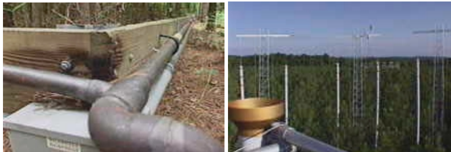
Teile der Begasungsanlage, mit deren Hilfe die Bäume mit Kohlendioxid begast werden.
