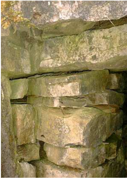
Die Steinverarbeitung auf der linken Seite des Zuganges.
