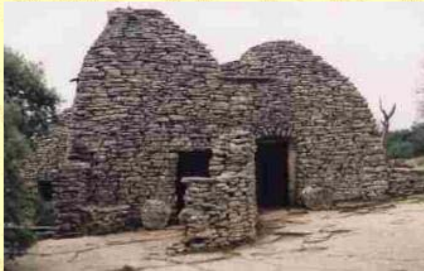
Abb. 10: Kuppelbauten von Les Bories (Frankreich)
