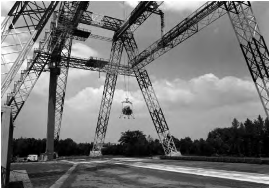
Traversenkrane auf dem NASA Langley Research Center in Hampton. Hier wurden Astronauten an Landefähren-Simulatoren geschult. Hier wurden auch die Landeszenen der einzelnen APOLLO-Missionen „auf dem Mond“ abgedreht (NASA-Bildnummer 00df58b0)
