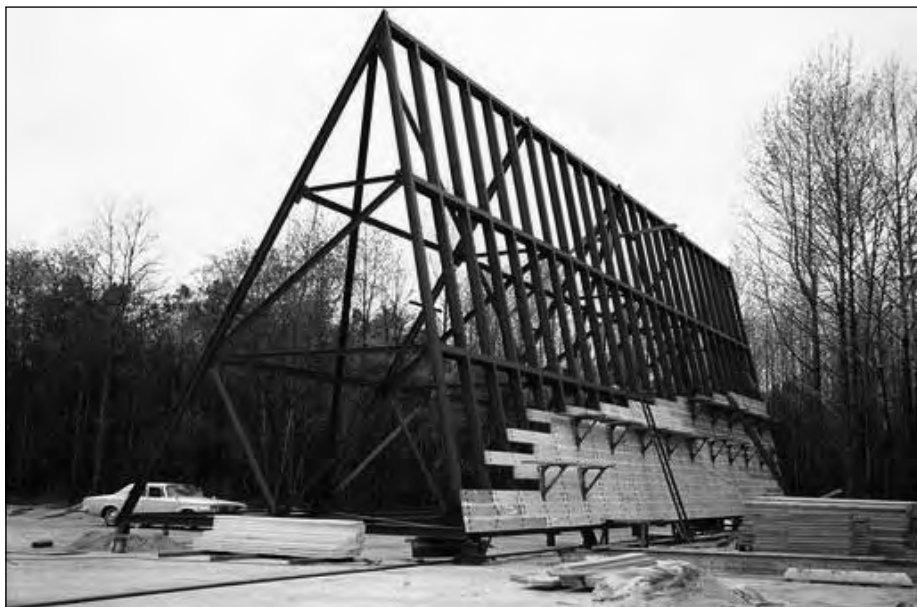
Eine Rückwand im NASA Langley Research Center, woran die Fototapeten des Mondhorizonts geklebt waren. (NASA-Bildnummer 05102950)
