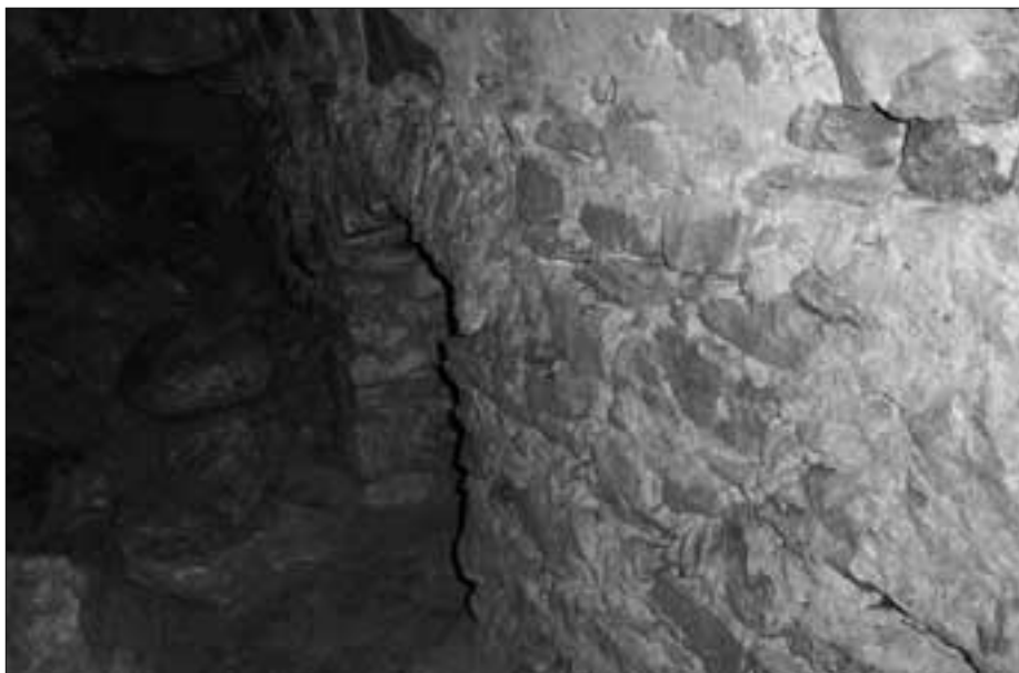
Bild 4: Ein Teil unter der Kirche ist aus Stein gemauert.
