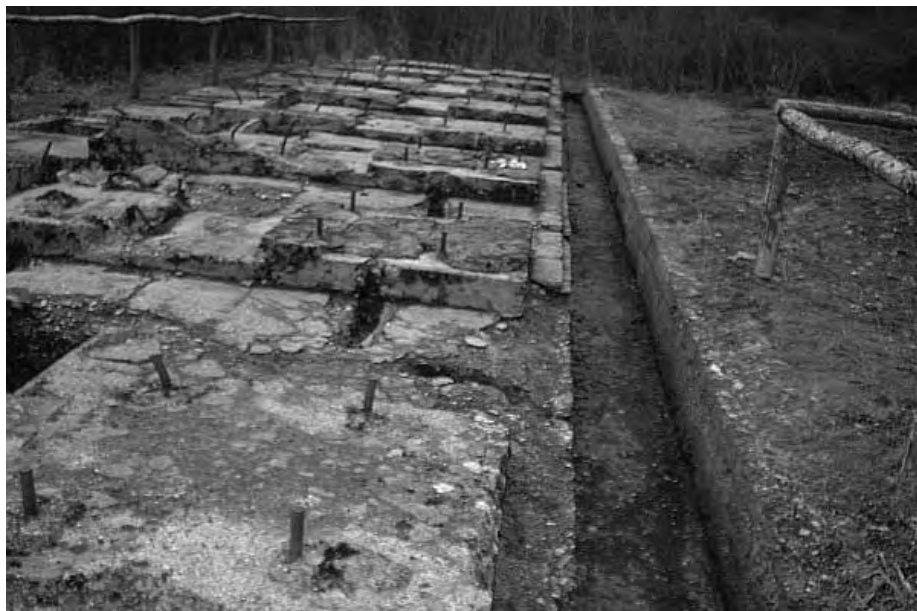
Bild 3: Fundamente der großen Kompressoranlage, die zum Betrieb der Bohrhämmer die nötige Druckluft lieferte (Alle Fotos: Wilfried Augustin)
