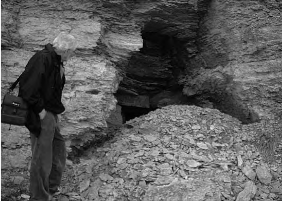
Bild 2: Verschüttete, teilweise auch nur vermauerte Stolleneingänge.
