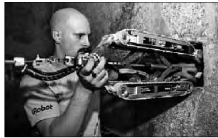
Der Miniroboter wird in den „Luftschacht“ eingeschoben.
