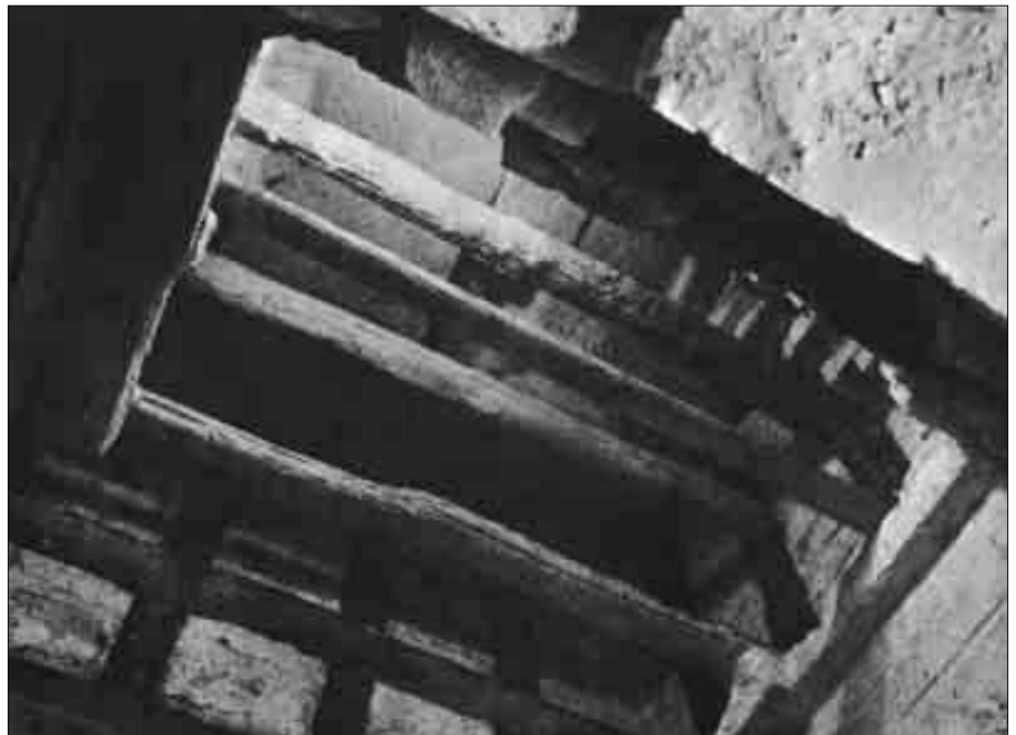
Im Inneren erkennt man eine unfertige Deckenkonstruktion aus Zedernholzbalken. Wurde die Pyramide nur äußerlich fertiggestellt?
