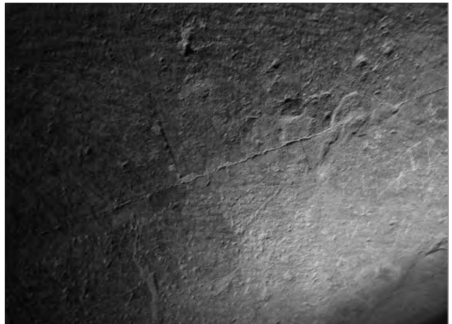
Die Steinverfugungen in der Großen Galerie lassen sich kaum erkennen. Man beachte, dass die riesigen Granitblöcke schräg gesetzt sind, im selben Winkel wie der Aufweg der Galerie.
