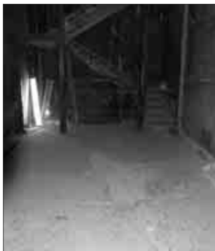
Der Boden der zweiten „Vorkammer“, im Hintergrund der hölzerne Treppenaufgang zum Durchgang zur „Grabkammer“.
