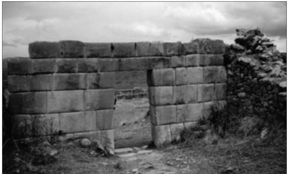
Abb. 20 – Die Ruinen von Huanuco Viejo, Peru. In der rechten Hälfte ist gut zu erkennen wie mit kleinen Steinchen ans polygonale Mauerwerk angebaut wurde.
