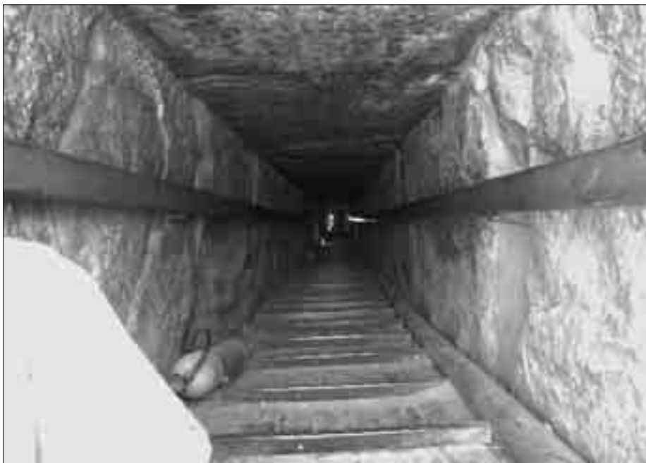
Der abwärts führende Gang hat gerade mal einen Durchmesser von rund einem Quadratmeter und führt rund 65 Meter in die Tiefe.
