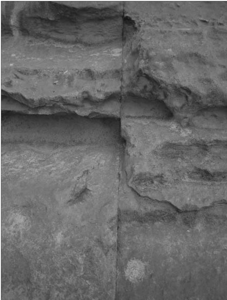
Auch hier wieder gut sichtbar: Die Steinblöcke passen mit einer außergewöhnlichen Genauigkeit zusammen, andererseits erkennt man den hohen Verwitterungsgrad.
