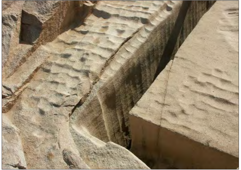
Der Obelisk hat mehrere Risse. Dies ist einer davon. Auch hier kann man schön die „Eislöffelchen“-Technologie erkennen, als ob der Granit weich wie Butter gewesen wäre.
