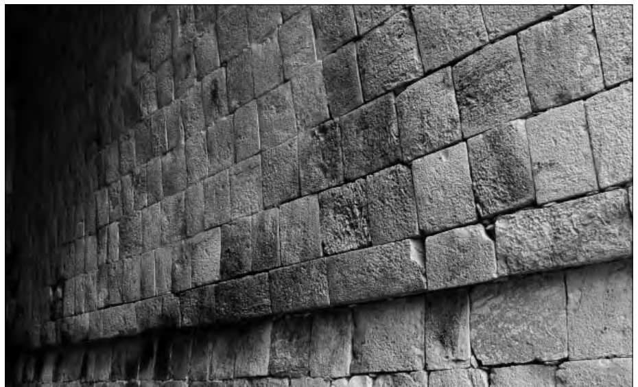
Bild 3: Fassade aus präzise eingesetzten Steinen
