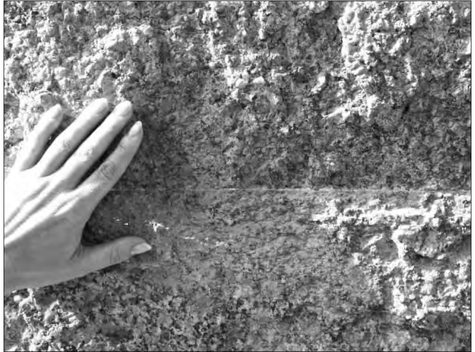
Fugenübergreifende Strukturen im Granit, die sich selbst auf kleinste Verfärbungen auswirken. Man beachte auch die Fuge, die nur Bruchteile von einem Millimeter breit ist! (Chephren-Taltempel)
