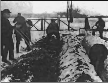
Letzte Kontrolle: „Graben fertig!“ (Original-Bildtext)
