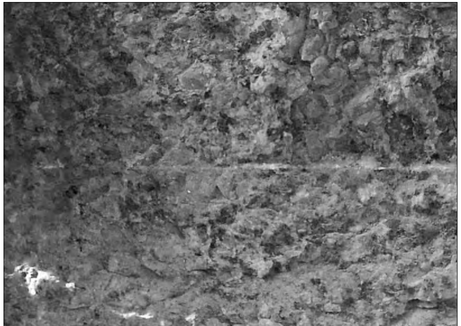
Die Ausschnittsvergrößerung aus obigem Bild zeigt deutlich die fugenübergreifenden Strukturen des Granits. Die Fuge selbst ist derart dünn, dass sie teilweise kaum erkennbar ist.
