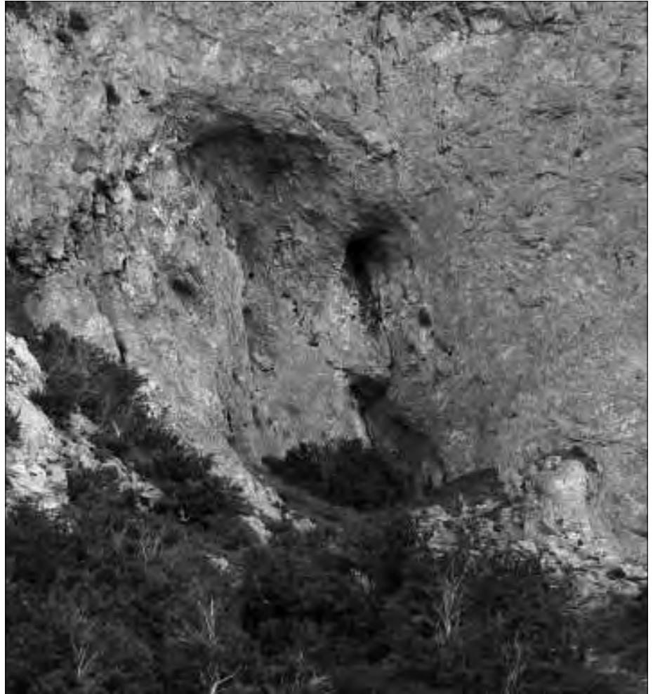
Bild 3: In Wirklichkeit ist das Loch nur eine Stelle, wo sich eine Kalksteinplatte aus dem Fels gelöst hatte.
