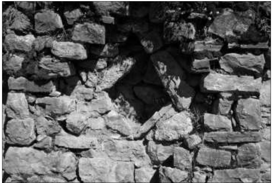
Abb. 13: Großansicht eines der drei in die Mauer eingebrachten Chacana.
