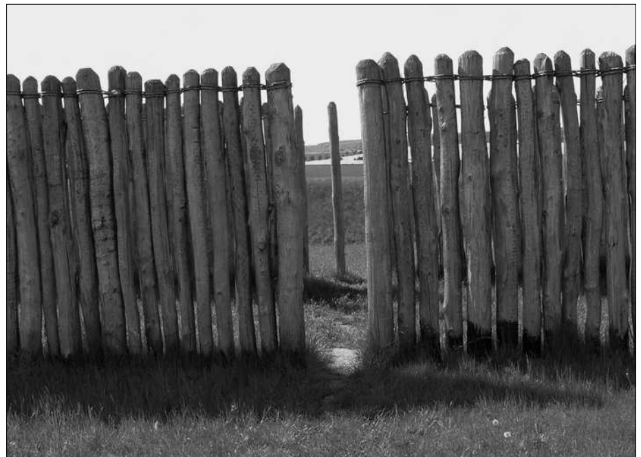
Bild 6: Lücken zwischen den Pfählen als Messpunkte
