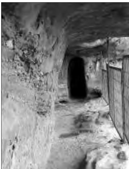
Bild 18: Das Wasser wird in einen unterirdischen Kanal geleitet.
