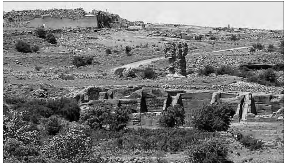
Bild 17: Ein Pfeiler des Aquäduktes steht noch.
