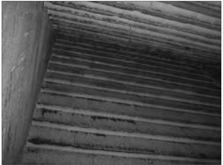
Das Kraggewölbe in der „Grabkammer“ der Roten Pyramide von Dahshur: Man sieht deutlich, dass an den Kragsteinen über eine gewisse Zeit (schmutziges) Wasser entlang gelaufen ist und seine Ablagerungen hinterließ.
