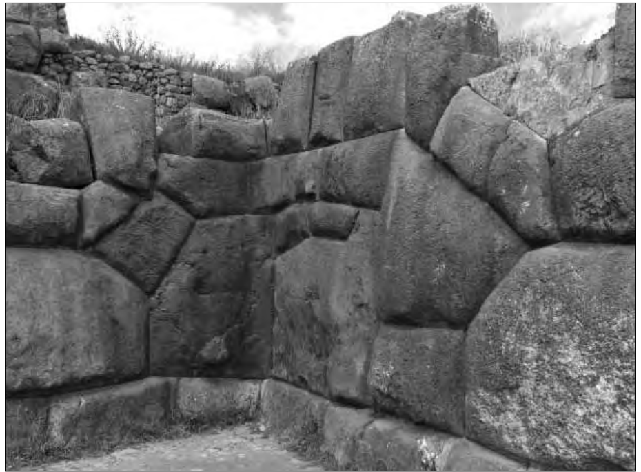
Sacsayhuaman (Peru): Wer hat die gigantischen Blöcke dorthin gestellt? Die Inka bestimmt nicht. Von ihnen stammen höchstens die Mauer-Ausbesserungen in der oberen Reihe.
