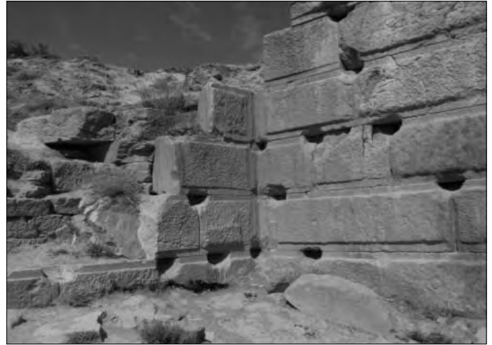
Abb. 26 - Stützmauerwerk (?) mit einer natürlich anmutenden Aufschüttung dahinter, teilweise höher als die Oberkanten der Wände selbst; alles konsequent in Klammertechnik. Ein Zweck dieses Komplexes ist rein vom Hinschauen her nicht mehr ersichtlich.
