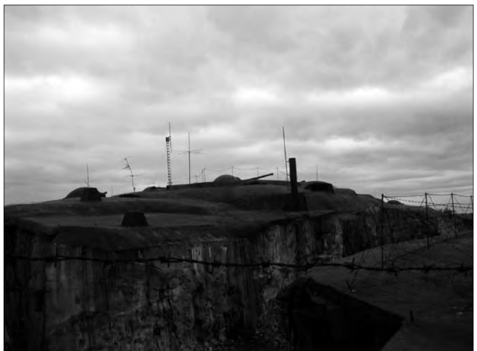
Oberirdischer Teil einer militärischen Untergrundanlage.
