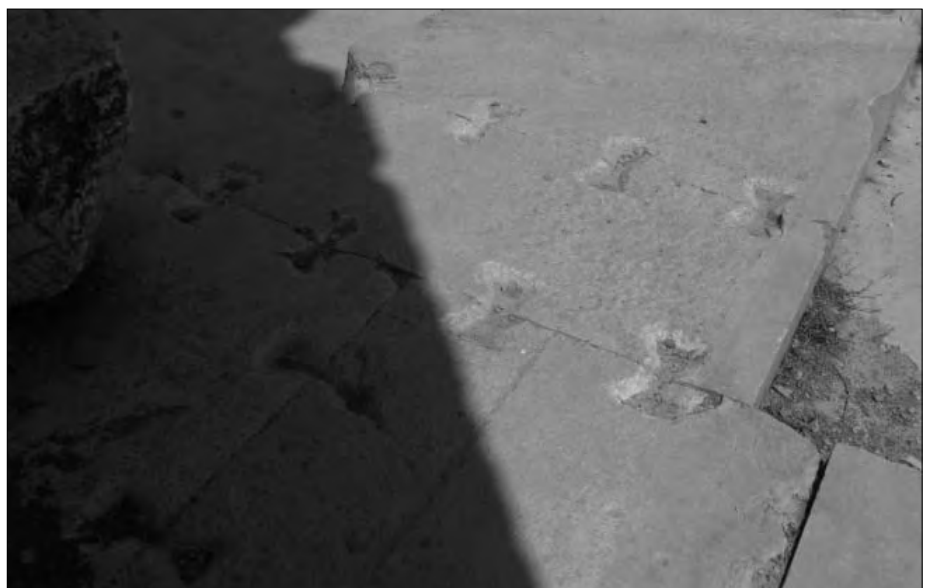
Abb. 33 - Der massive Boden ist mit Klammern regelrecht gepflastert. Auch diese Aufnahme könnte aus der andinen Hochebene stammen!
