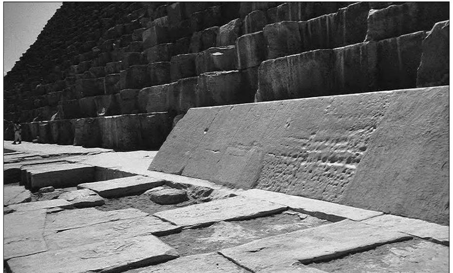
Abb. 25: Nordseite der „Cheops-Pyramide“; an der untersten Ebene ruhen einige Kalkstein-Fassadenblöcke. Original oder nur für die Touristen nachträglich fabriziert und herangeschoben? Vergleiche hierzu auch Abb. 8a. Das sind Originale! Hier ist auch gut die weitflächige Pflasterung um die Pyramiden herum zu erkennen, soweit noch erhalten.
