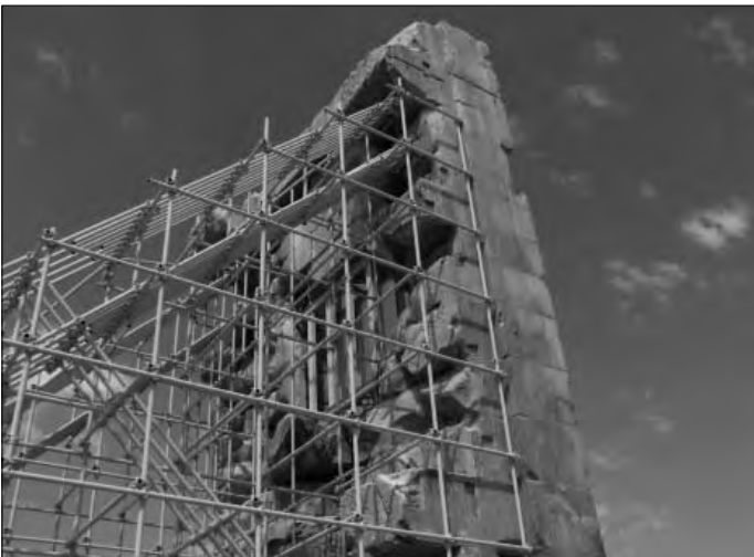
Abb. 29 - Das etwa 10 m aufragende Gebäudefragment von der Seite aus gesehen. Eine aufwändige Stützvorrichtung bewahrt es vor seinem endgültigen Zerfall.
