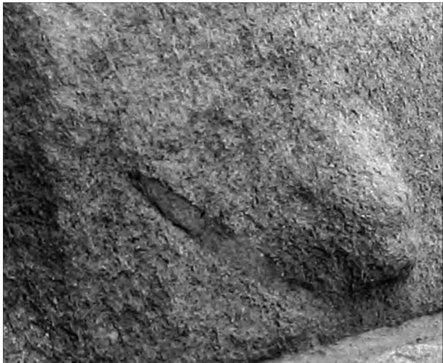
Bild 2: Hier eine Reparaturstelle. Es wurde gemörtelt (Mykerinos-Pyramide, Gizeh).
