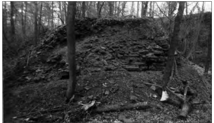
Abb. 27: Die Freilegung der Vorderseite brachte das sorgfaltig und trocken gefugte Mauerwerk aus rechteckigen Sandsteinen zutage.
