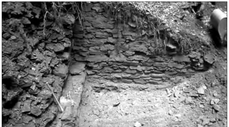
Abb. 4: Mauerwerk mit Grund- und Stützmauern.
