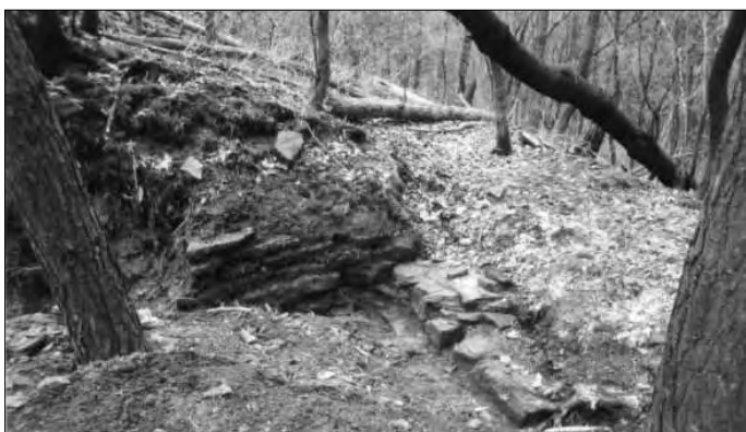
Abb. 24: Die Wehrmauer von oben betrachtet.
