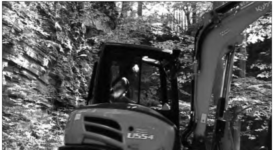
Abb. 3: Herr Nuber von der gleichnamigen Firma handhabte den Bagger mit Bravour.
