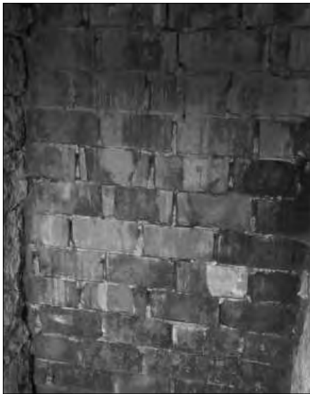
Abb. 22b: Vermauerter Keller in einem Wengerthäuschen.
