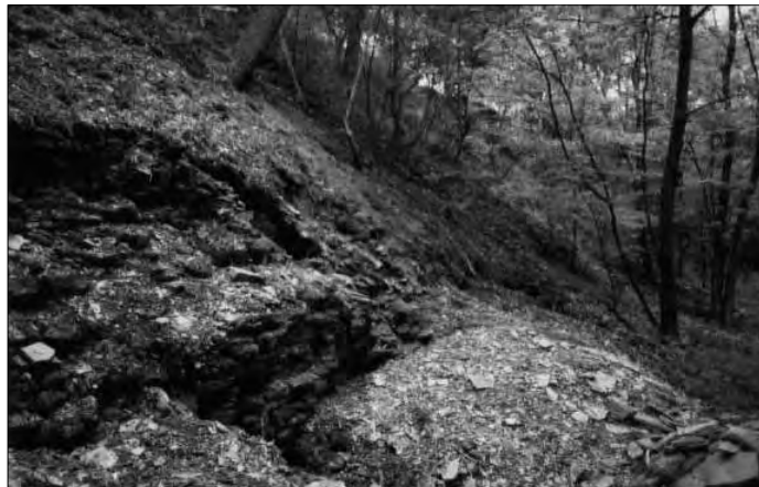
Abb. 22: Auf diesem Bild wird erkennbar, wie steil das Bauwerk immer noch ist.
