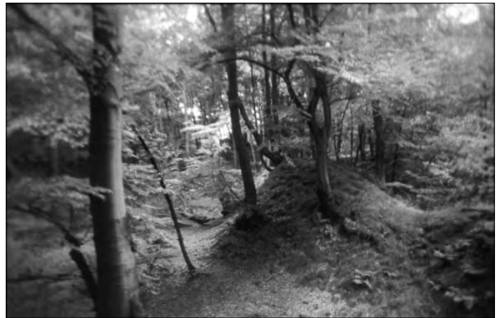
Abb. 9 - An den Einsturzkratern auf der Kuppe treten immer die Bruchsteine zutage, aus denen das ganze riesige Bauwerk besteht.
