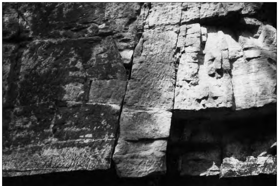
Abb. 12: Die Basismauer an der Ostseite der groen Pyramide zeigt solide Schilfsandsteinplatten im Fassadenbereich, aber auch Tonschieferplatten als Hinterfullung.
