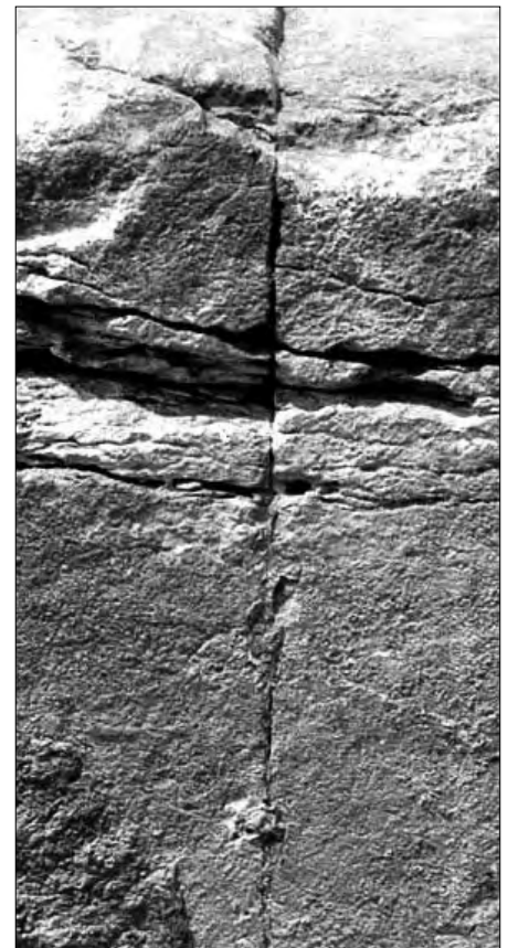
Bild 4: Senkrechte Trennfuge. Es sieht so aus, als würden hier zwei behauene Blöcke aneinanderstoßen (Cheops-Pyramide, Gizeh).
