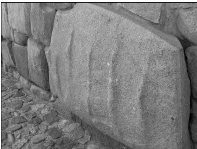
Cuzco, Inkastraße: An diesem verbauten Andesit-Steinblock erkennt man sehr gut die angewendete „Eislöffelchen“-Schabemethode an weichem Gestein.
