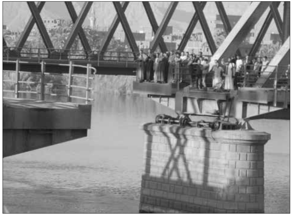
An der Schleuse Naga Hammadi.
