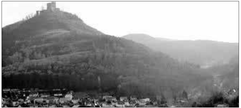
Abb. 12: Burg Trifels, Annweiler.
