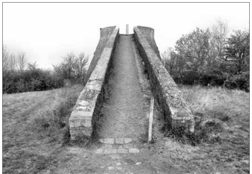
Bild 3: Der Aussichtsturm mit Aufgangsrampe.
