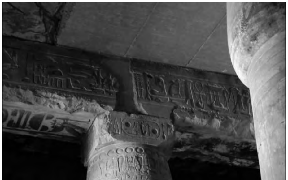
Bei näherem Hinschauen erkennt man, dass der eigentliche Steinblock mit einer Mörtelschicht versehen ist, die teilweise abgebrochen ist, worin die Hieroglyphen eingearbeitet wurden.
