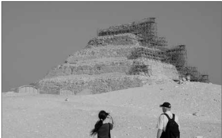
Die Stufenpyramide von Saqqara ist zum großen Teil wegen Einsturzgefahr eingerüstet.
