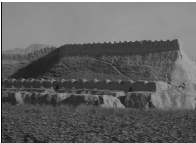
Abb. 7: Befestigungsanlage bei Balkh.
