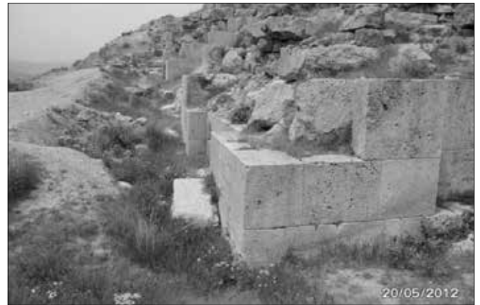
Bild 6: Mauer, aus tadellos rechtwinkligen Quadern hergestellt.
