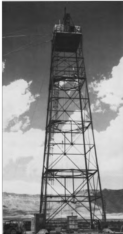
Der 30 m hohe Stahlurm in Alamogordo/USA, auf dem eines der drei einsatzfähigen deutschen Beutestücke für einen Funktionstest geopfert wurde.
