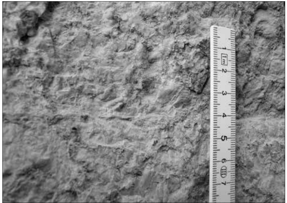
Chephren-Tempel in Gizeh: Zwei aufeinander verbaute tonnenschwere Granitblöcke. Sie wurden ohne Schnittabfall geschnitten und in gleicher Reihenfolge verbaut, wie sie im Steinbruch abgebaut wurden. Die Trennlinie zwischen den Blöcken verläuft in Höhe der 4-cm-Markierung auf dem Maßstab. Man erkennt relativ deutlich, dass sich selbst kleinste Strukturen über die Schnittstelle hinweg fortsetzen.
