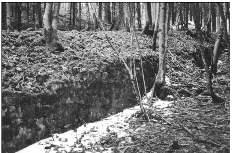
Abb. 5: Am Westhang des Schürlebachtals befindet sich dieser 2,5 m breite Mauerrest. Rechts im Bild ist die Mauer stellenweise schon zum Steinwall mutiert.
