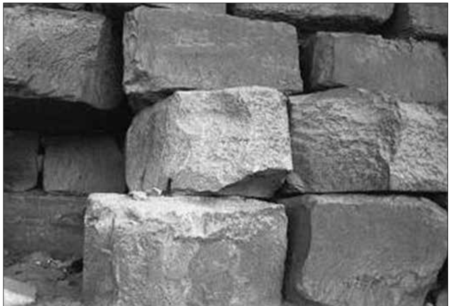
Abb. 3 - Eindeutig lose aufeinandergestapelte Blöcke an der Knickpyramide in Dahshur.
