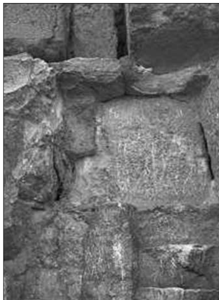
Abb. 5 (links) - Völlig unregelmäßige Verlegung an der Cheopspyramide. Abb. 6 (rechts) - Antike Mörtelfüllung zwischen den Blöcken, Cheopspyramide.
