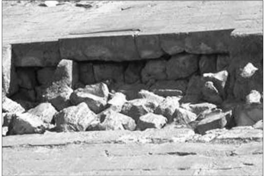
Abb. 2 - Unregelmäßige Blöcke unter dem Stufenmantel in Meidum.
