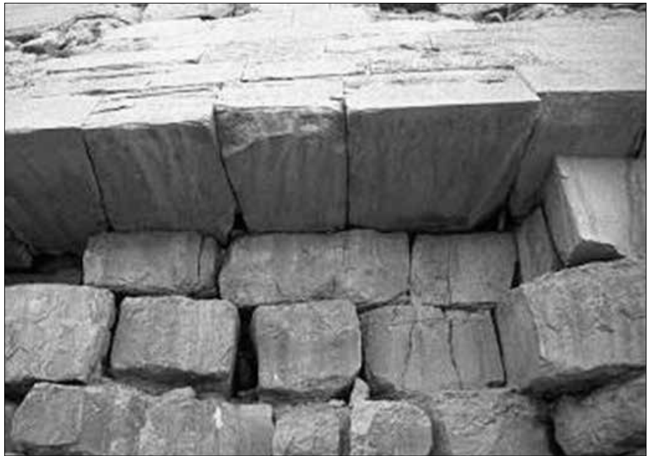
Abb. 4 - Unregelmäßige Blöcke an verwitterungsgeschützter Stelle, Knickpyramide (Dahshur).
