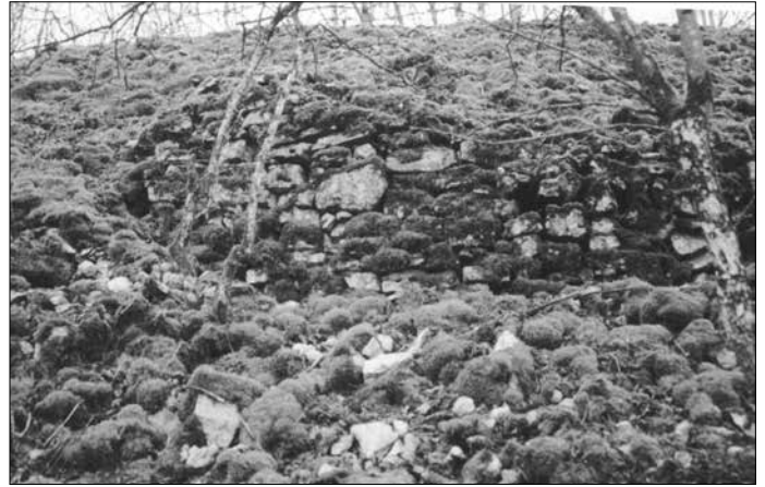
Abb. 18 (links): Ein von unten gesehen ca. 5 m hoher Steinwall (Mauerrest) am Nordwesthang des „Stubenbergs“ - die Mauerfront ist talwärts (nach rechts hinten) abgerutscht, und fehlt heute. Rechts wurde der Wall illegalerweise angegraben (Landschaftsschutzgebiet!), sodass man gut die Splittfüllung der ehemaligen Mauer erkennen kann. An der Rückseite (links unter dem Anthropologen H. Kalweit) findet man noch gut erhaltenes, aber hier stark bemoostes Mauerwerk.
