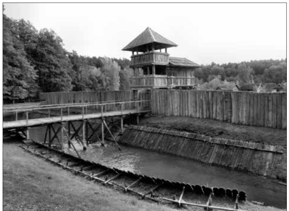
Bild 6: Palisadenmauer und Tor.
