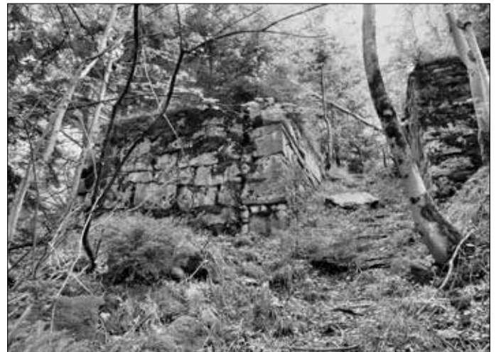
Bild 6: Ruinen am Zugang zum alten Steinbruch.
