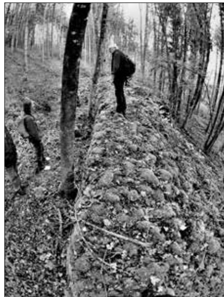
Bild 25: Trockenmauer, Abgrenzung zum Talgrund.
