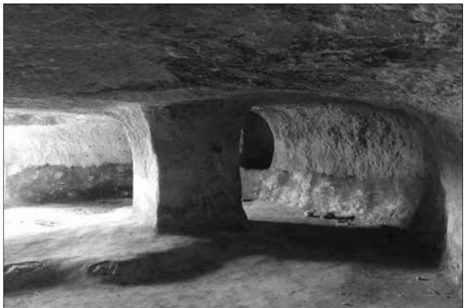
Bild 10: Algenschicht an der Wand.
