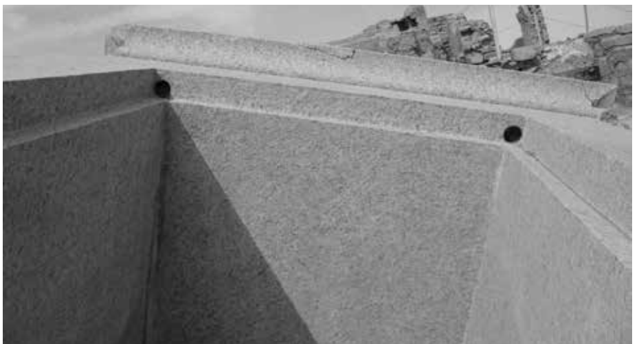
Ein Blick ins Innere zeigt die ausgesprochen exakte Bearbeitung. Oben und unten befinden sich in den Ecken je 6 cm durchmessende Kernbohrungen, die wohl einst der Aufnahme von Türangeln dienten.
