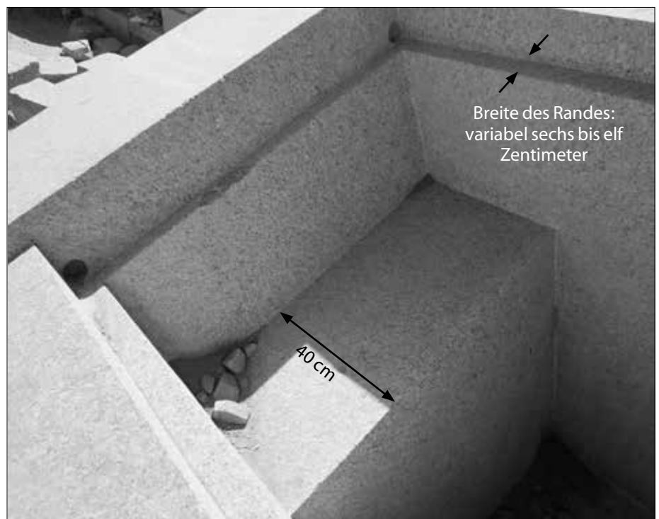
Blick in den Innenraum mit der Stufe, auf der eine Götterstatue gestanden haben soll. Oben links und rechts sind zwei der Kernbohrungen erkennbar. Sie haben jeweils einen Durchmesser von sechs Zentimetern und sind jeweils fünf Zentimeter tief in den Granit eingelassen. Auf diesem Bild nicht erkennbar: Knapp oberhalb der Stufe verläuft eine mit Rötelfarbe angebrachte Linie rund um den Innenraum.
