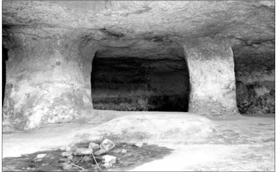
Bild 8: Höhlung mit Terrazzo-Fußboden.
