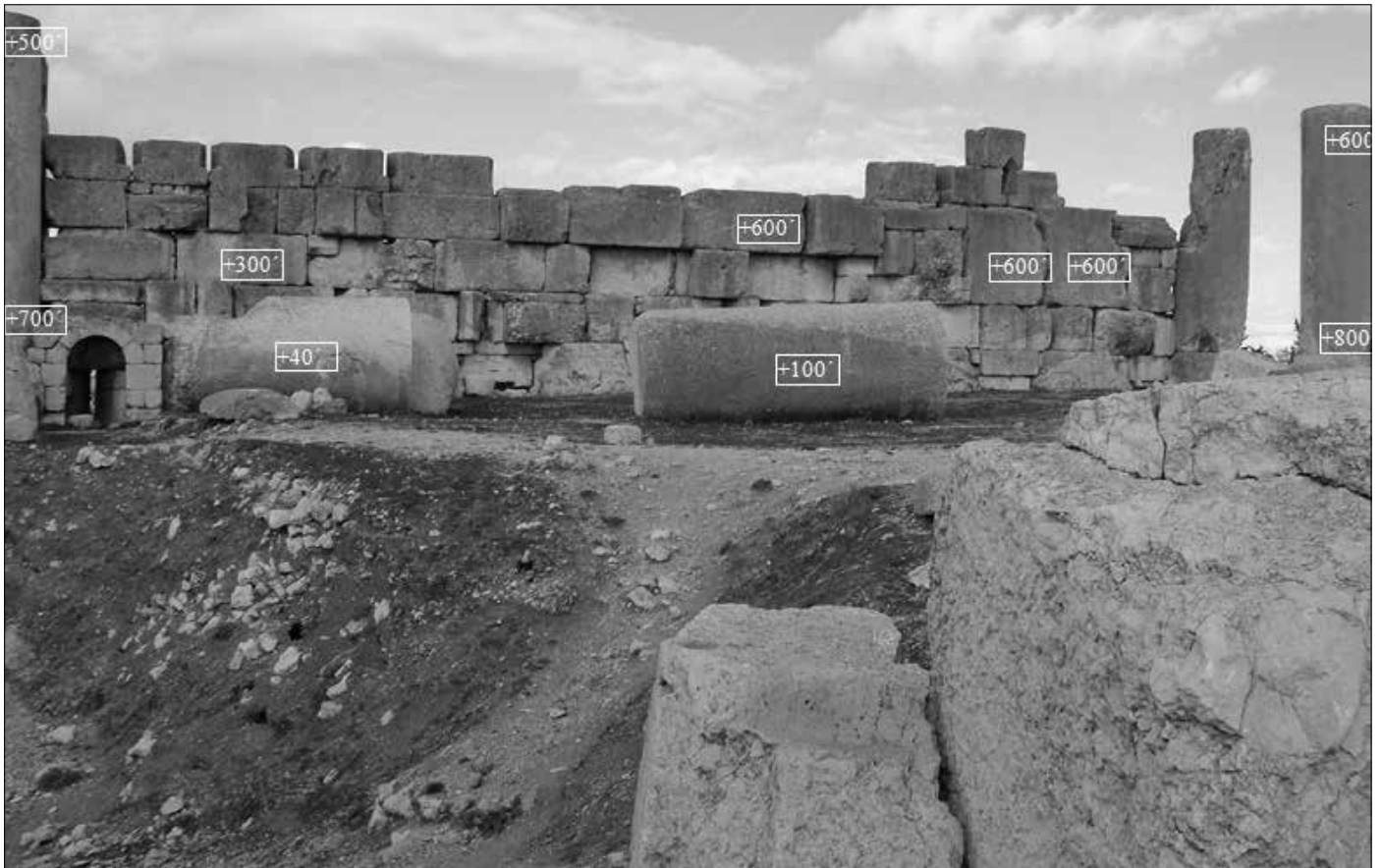
Bild 7: Welche Chaoten versuchten hier, ein Bauwerk aus vorhandenem Material zu errichten? Es ist doch erbärmlich. Diejenigen, die die Steine einst schufen, müssten sich ja im Grabe herumdrehen, wenn sie dies sähen. Sind denn nach dem Erdbeben nur die Dämmsten und Primitivsten übrig geblieben?
