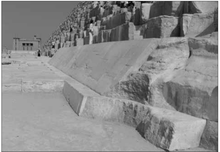
Nordseite der Cheopspyramide. Auch hier hat Mark Lehner eine Reihe „Verkleidungssteine“ verlegt, die von den Touristenführern als „echt“ bezeichnet werden. Allerdings liegen sie im falschen Böschungswinkel.
