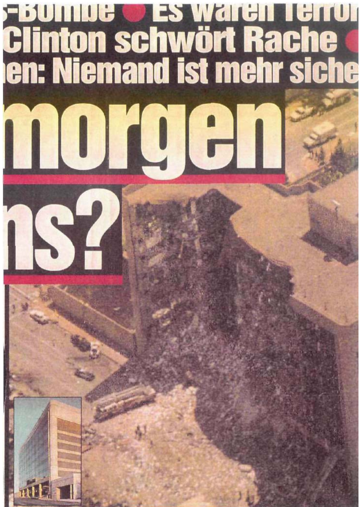
Bild 11: Vernichtung eines Regierungsgebäudes mit FBI-Büros in Oklahoma City. Gut erkennbar der "Herausschnitt" aus dem Gebäude (Beschreibung S. 75).
