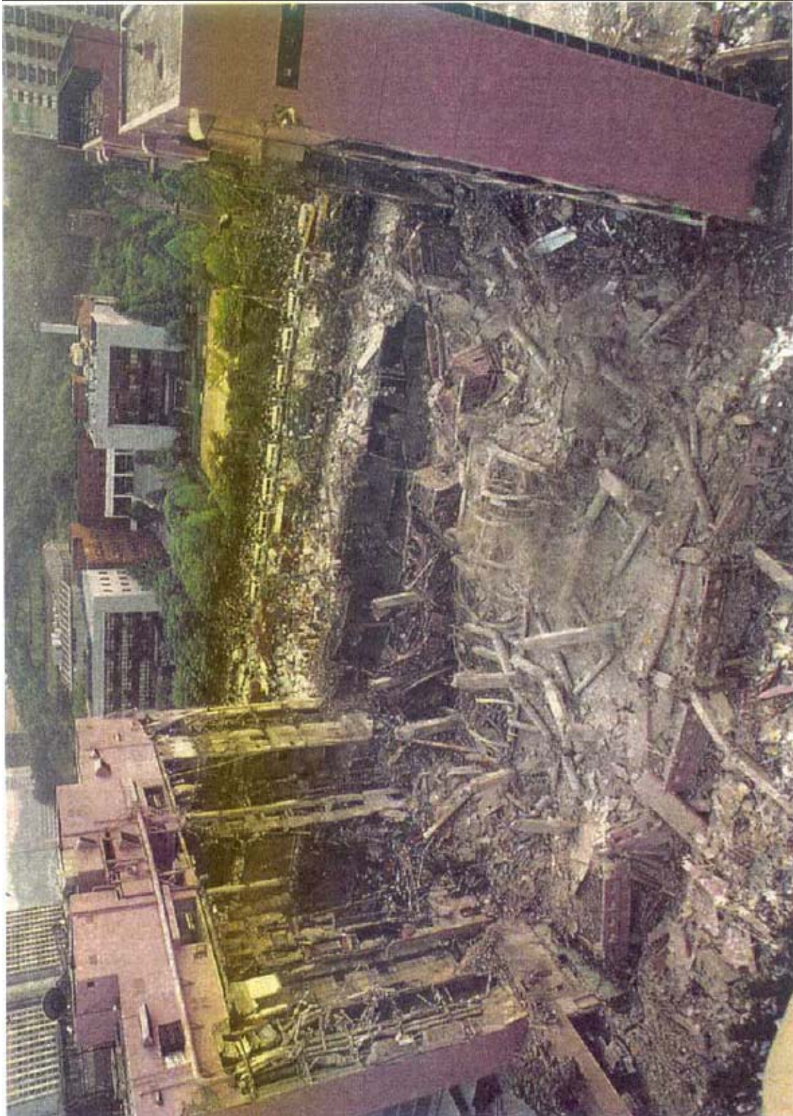
Bild 17: Der "5-Sekunden-Schnitt" am Kaufhaus "Sampoong" in Seoul, Korea (Beschreibung Seite 123). Aufnahme aus "Jyllands Posten" vom 30.6.95.
