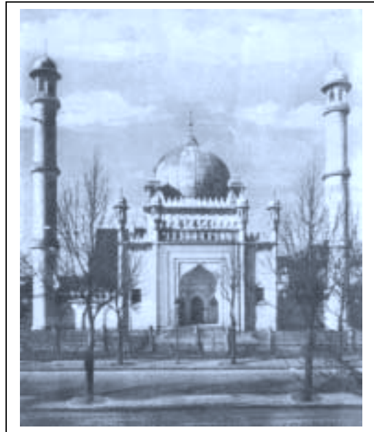
Die Berliner Moschee kurz nach der Errichtung
