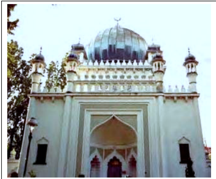
Die Berliner Moschee vor den Restaurierungsarbeiten im Jahre 2005
