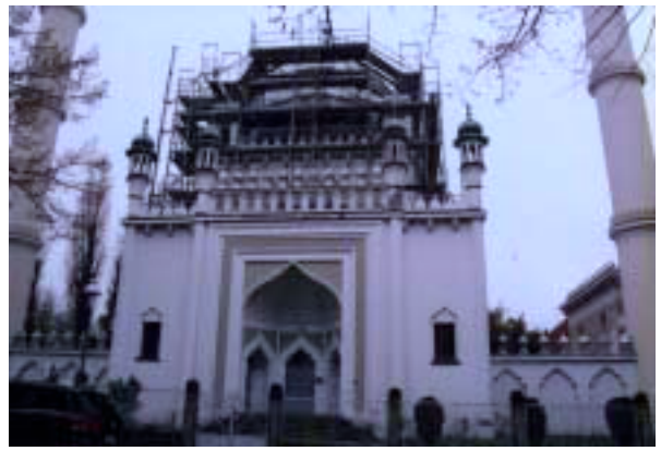
Beginn erneuter Restaurierungsarbeiten an der Kuppel im Jahre 2005
