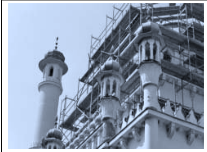
Details des Hauptgebäudes der Berliner Moschee; zu sehen ist außerdem das Gerüst für die erneuten Restaurierungsarbeiten im Jahre 2006
