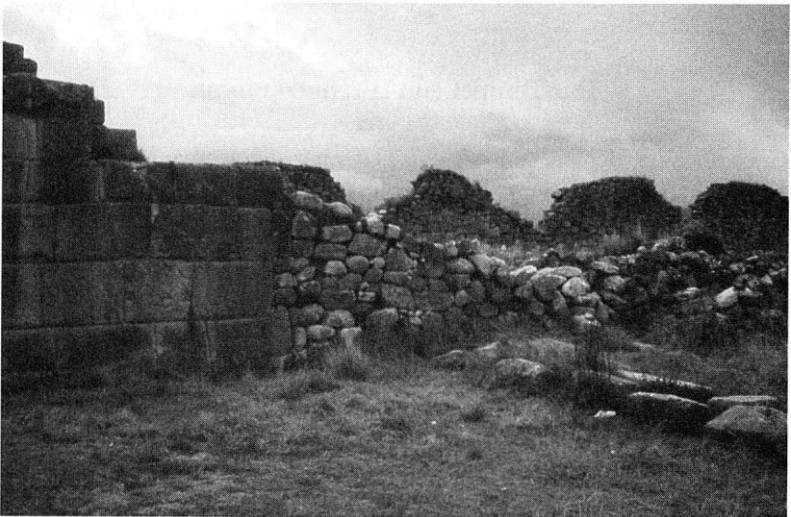
Krasser kann der Unterschied nicht sein: desolat der Zustand im »Anbau« im Vergleich mit den Mauern älteren Datums, (alle Fotos: Hartwig Hausdorf)
