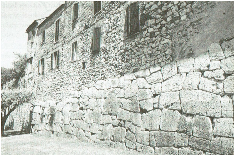
Der Endabschnitt der rechten Seite des Portals, gegen Westen betrachtet. Am Ende ist eine Unterbrechung ersichtlich, an der eine normale Bauweise beginnt. Später wird die polygonale Bauweise wieder aufgenommen. (Foto: Broussard)
