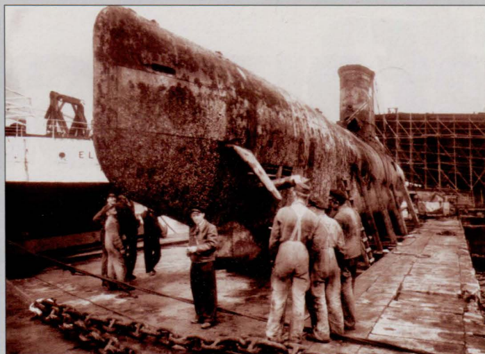
1956 wurde das ehemalige U-Boot U 2365 im Kattegat gehoben und bei den Kieler Howaldtswerken instandgesetzt, bevor es als „U-Hai“ zur Marine kam.
