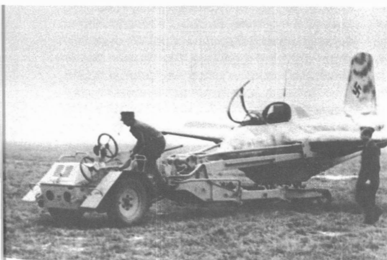
Oben: Alternative Schlepplmöglichkeit beim JG 400 in Brandis aufgrund der angespannten Betriebsstofflage.
