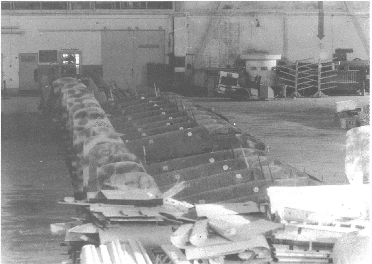
14 Me 163 B in Kiel-Holtenuau vor dem Abtransport.
