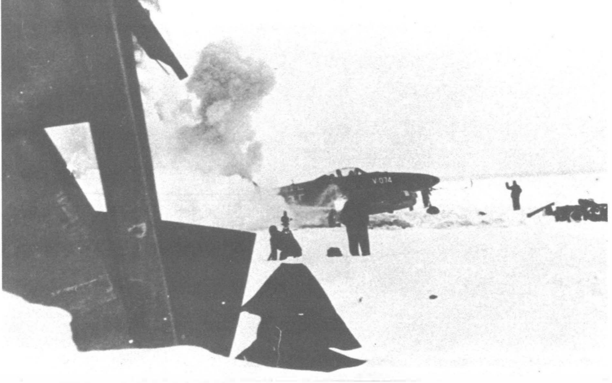
Explosion der rechten Brennkammer des ersten Musterflugzeugs der Me 262 C-2b am 25. 01. 1945 in Lechfeld.
