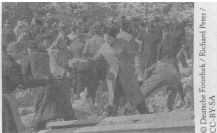
Enttrümmerungsarbeiten in Dresden im Frühherbst 1945 - Transport geputzter Ziegel von Hand zu Hand.
