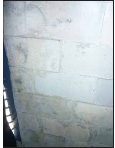
Abb. 23: Neu eingefügte Fliesen bzw. nachgemachte Mörtel- "Fliesen" um die Einwurfschächte.
