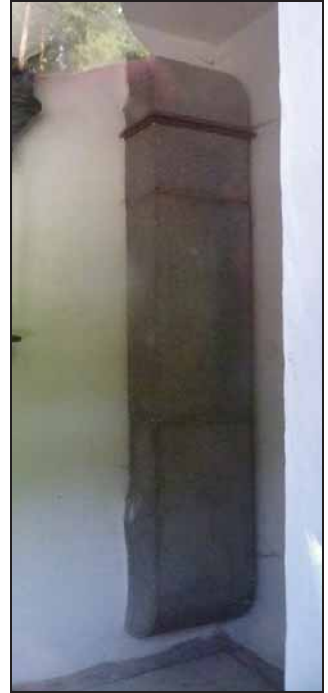
Abb. 26: Warmluftzufuhrschacht hinter der Dachauer Gaskammer.
