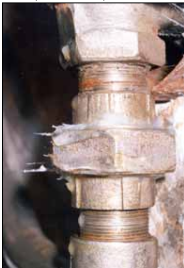
Abb. 107: Nahaufnahme einer Rohrleitung unterhalb der Gaskammer, mit Vaseline bestrichen zur Aufspürung von Lecks.
