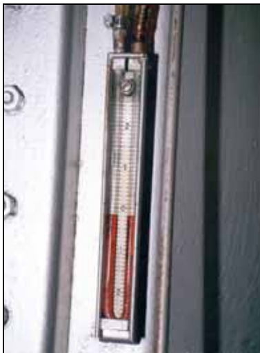
Abb. 111: Manometer zur Überwachung des relativen Gasdrucks.
