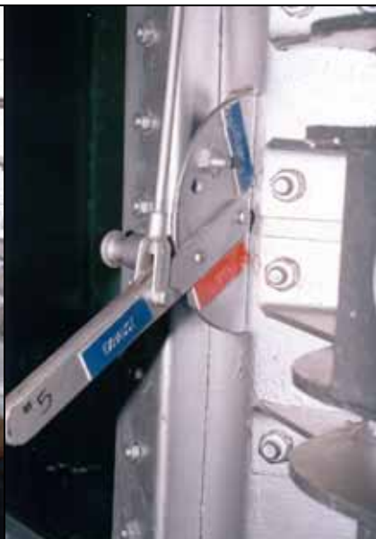
Abb. 100: Nahaufnahme des Hebels, mit dem der Abluftkamin geschlossen bzw. geöffnet wird.
