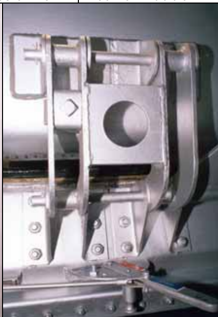
Abb. 106: Nahaufnahme der Scharniere der Gaskammertüre.
