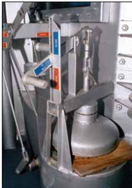
Abb. 99: Nahaufnahme der Frischluftzufuhr der Gaskammer.
