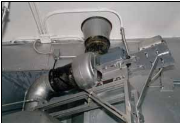
Abb. 103: Abluftgebläse über der Gaskammer.
