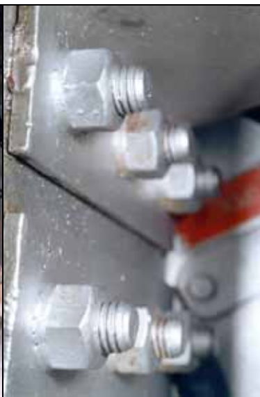
Abb. 110: Nahaufnahme der Bolzen der Türscharniere.
