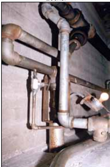
Abb. 109: Teil der Rohrleitungen und des Abflusssystems, das den Chemikalienraum mit der Gaskammer verbindet.
