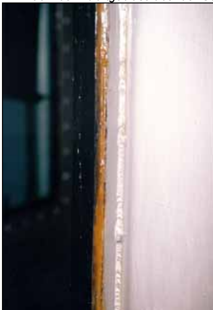
Abb. 105: Nahaufnahme der Gummidichtung am Rande der Gaskammertür, bei Benutzung zusätzlich mit Vaseline bestrichen.
