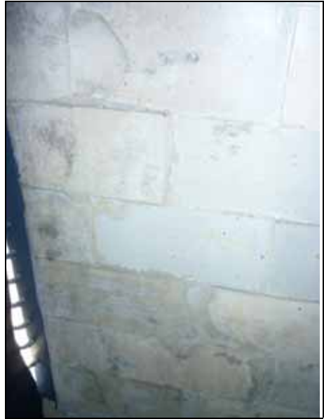
Abb. 52: Neu eingefügte Fliesen bzw. nachgemachte Mörtel-„Fliesen“ um die Einwurfschächte.
