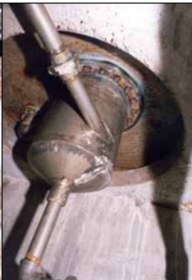
Abb. 108: Aufnahme der Rohrleitungen aus rostfreiem Stahl und des Chemiebehälters unter dem Sitz der Gaskammer.
