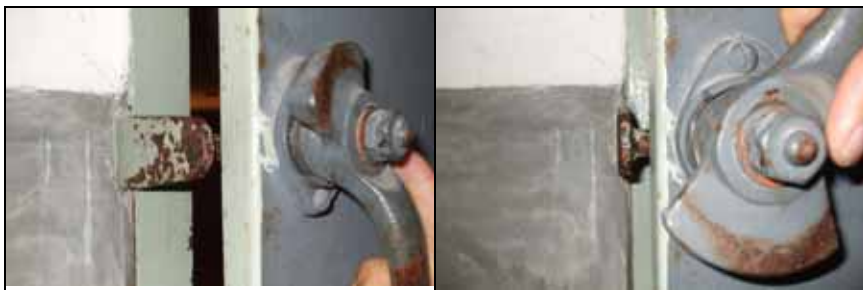
Abb. 61a & b: Heute können die Türen zur angeblichen Gaskammer in Dachau nicht geschlossen werden: der fehlende Schließmechanismus und an den Rahmen geschweißte Stahlstifte verhindern dies.
