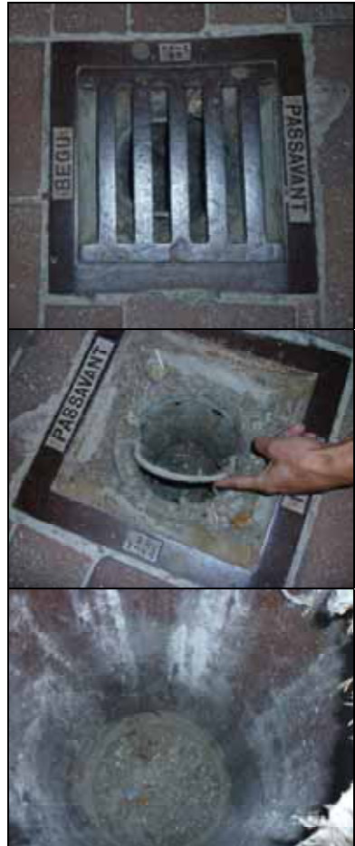
Abb. 62a-c: Oben: Einer der sechs Abwassergullys in der angeblichen Gaskammer des KL Dachau. Mitte: Deckel entfernt, Henkel des Siebes angehoben. Unten: Sieb entfernt. Am Boden des Topfes, auf dem Bild oben, leicht links versetzt, befindet sich das große Abflussloch.
