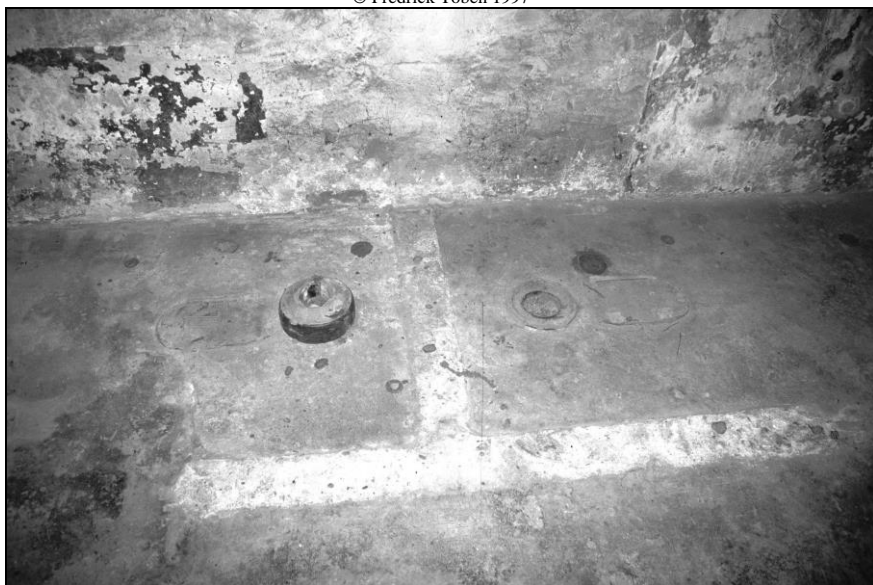
Dokument 35: Auschwitz, altes Krematorium, Toilettenabflüsse des vormaligen Luftschutzbunkers, jetzt in dem Teil gelegen, der fälschlich als “Gaskammer” ausgegeben wird. © Fredrick Töben 1997
