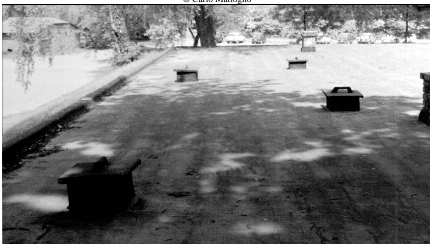
Dokument 23: Fotografie des Daches der Leichenhalle. Die vier von den Polen nach dem Krieg gebauten Schächte. © Carlo Mattogno
