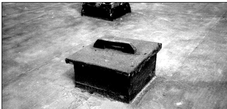
Dokument 24: Fotografie des Daches der Leichenhalle. Einer der vier von den Polen erbauten Schächte. © Carlo Mattogno
