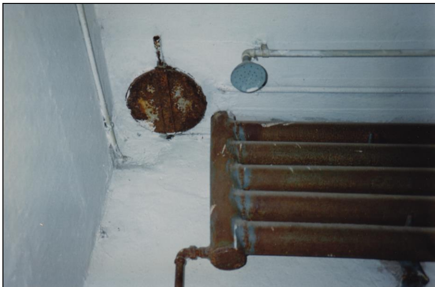
Foto 7: "Gaskammer" von Mauthausen: Deckel der Öffnung des Entlüftungsrohrs und Teil des Heizkörpers. Dezember 1990. © Carlo Mattogno.
