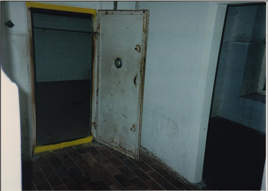
Foto 2: "Gaskammer" von Mauthausen: eine der beiden Türen, von innen gesehen. Dezember 1990. © Carlo Mattogno.
