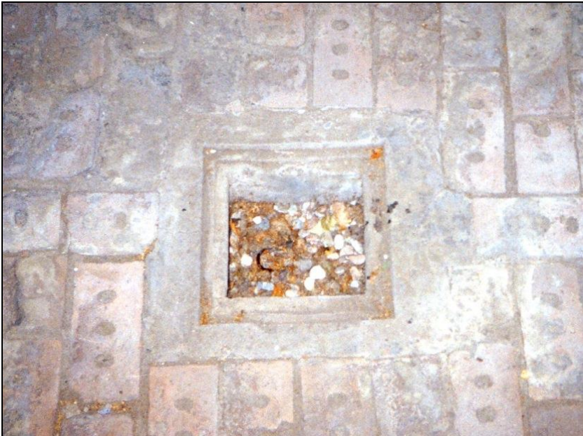
Foto 13: Entlausungskammer in Stutthof, Inneres. Entwässerungsschacht in der Mitte des Ziegelbodens unter der Zyklon-Einwurfluke. © Carlo Mattogno
