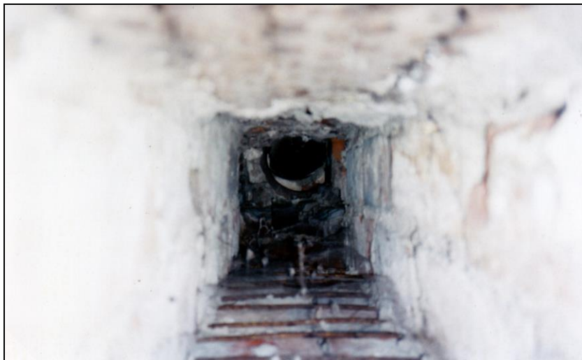
Foto 7: Entlausungskammer in Stutthof, Südseite. Ofen zum Erhitzen der Luft in der Gaskammer. Inneres der Brennkammer. Unten sieht man den Planrost, oben die runde Öffnung der Verbindung mit dem in der Entlausungskammer angebrachten gusseisernen Rohr.
