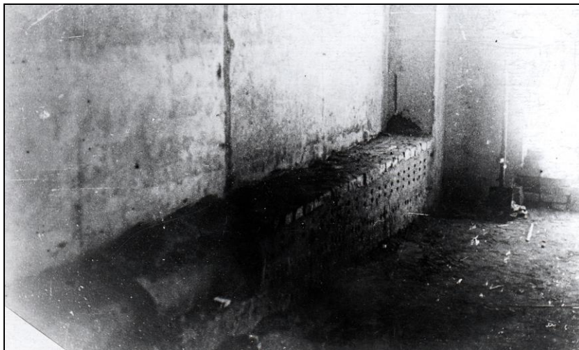
Foto 10: Innenaufnahme der Entlausungskammer in Stutthof, Westwand; gusseisernes Verbindungsrohr zum außerhalb der Gaskammer angebrachten Ofen, der zum Erhitzen der Luft diente. Das Rohr ist halb mit gelöcherten Backsteinen bedeckt. Originalzustand. Sowjetisches Foto vom Mai/Juni 1945. GARF, 7021-128-252.
