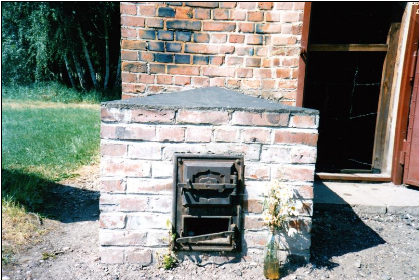
Foto 6: Entlausungskammer in Stutthof, Südseite. Ofen zum Erhitzen der Luft in der Gaskammer. Oben ist die Feuerungstür, unten die Aschentür zu erkennen. © Carlo Mattogno
