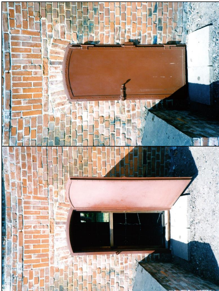
Foto 3: Entlausungskammer in Stutthof, Südseite. Heutige Tür. Es handelt sich um eine leichte Blechtür, die dem musealen Schutz des Raums dient. © C. Mattogno
