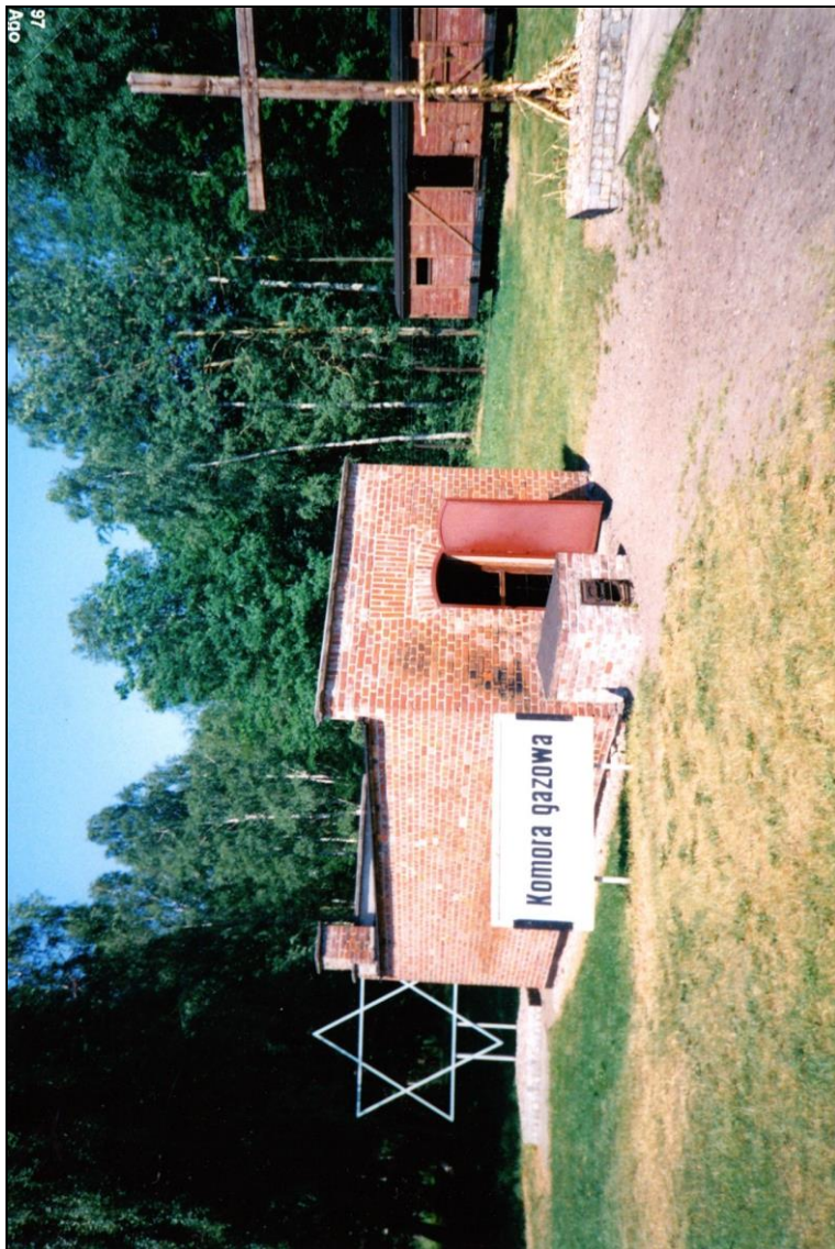
Foto 1: Entlausungskammer in Stutthof, heutiger Zustand (1997), südwestlicher Rand. Rechts sieht man einen der beiden auf der Schmalspur stehenden Waggons. © Carlo Mattogno
