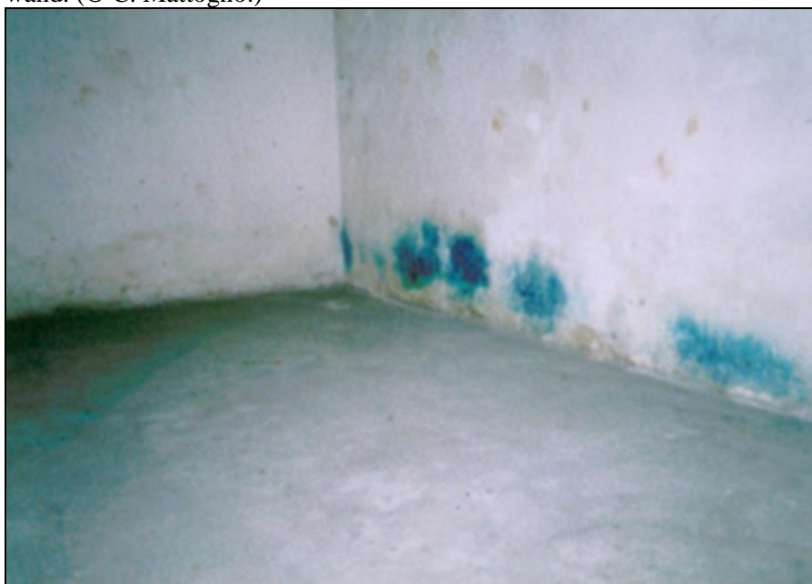
Fotografie XIV: Entwesungsanlage bei der Baracke 41, Kammer II, Westwand. (© C. Mattogno.)
