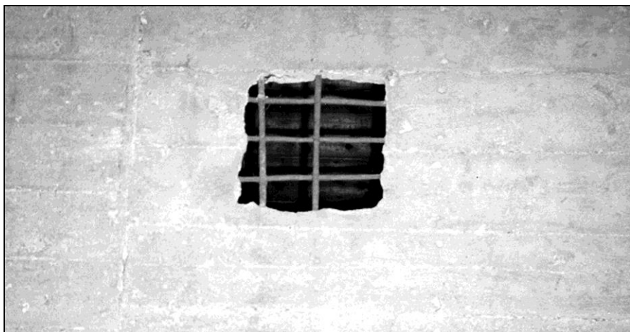
Fotografie XXI: Neues Krematorium, angebliche Menschentötungsgaskammer, Öffnung in der Decke. (© C. Mattogno.)
